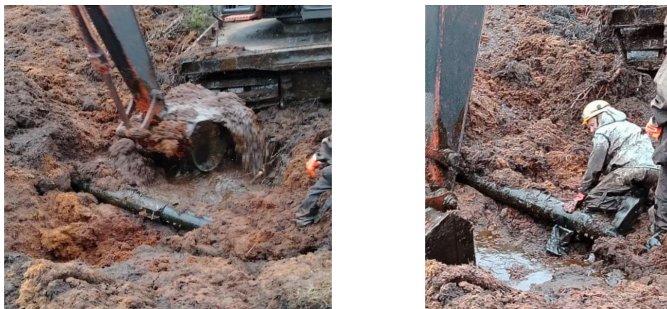
Рис. 1. Фото с места проведения ремонтных работ
